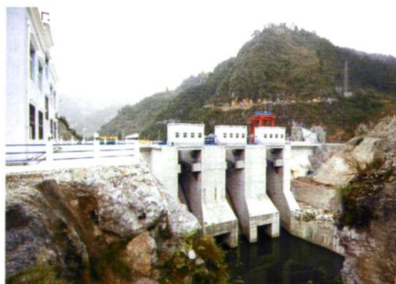
大龙潭水电站（2006年摄）
