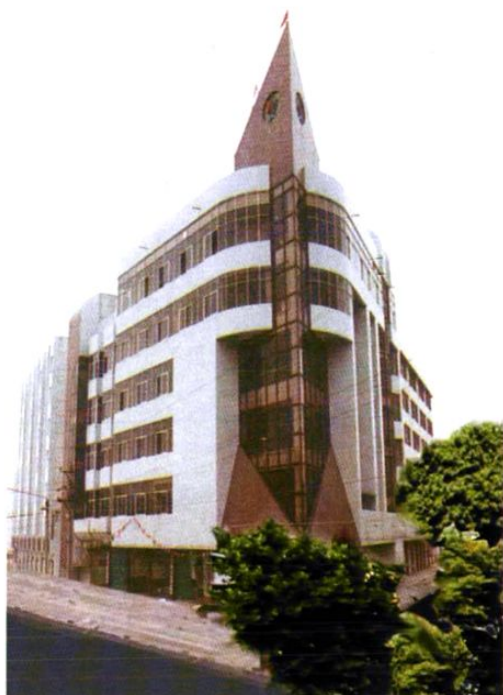
原恩施市电力公司调度综合楼（2005年摄）
