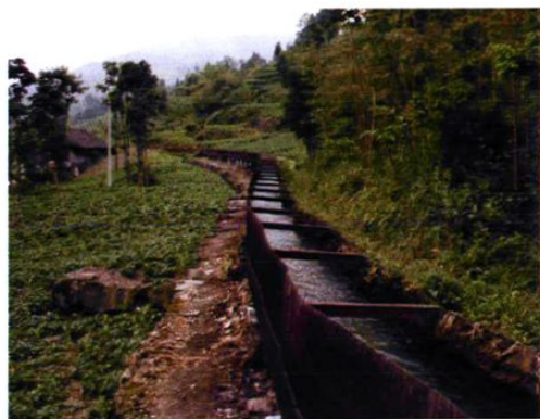
太阳河板桥电站引水渡槽 (2006年摄)
