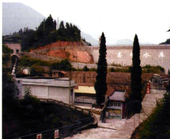
市境首座水力发电站高桥坝水电站（2005年摄）
