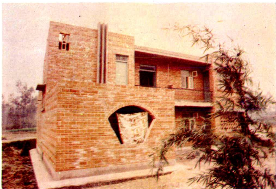
双桥区农村住宅一例
