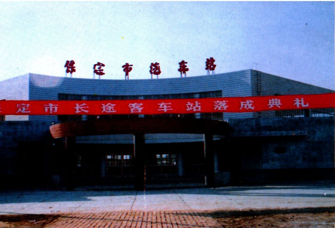
北省第一座市级公用型客车站——保定市汽车站外貌（1990年）
