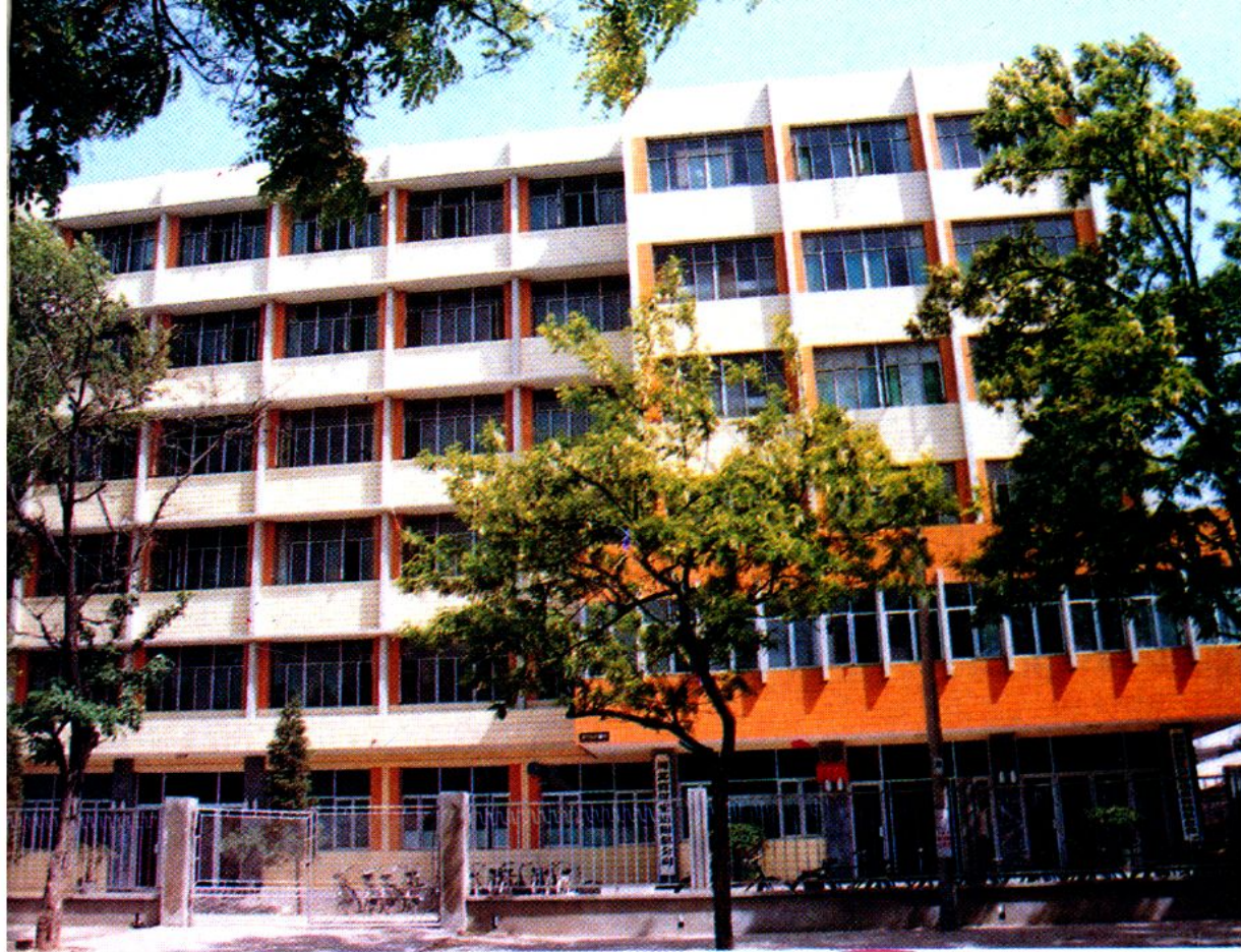
保定地区国营公路运输企业 保定地区 保定运输 总公司的机关办公大楼（1989年）
