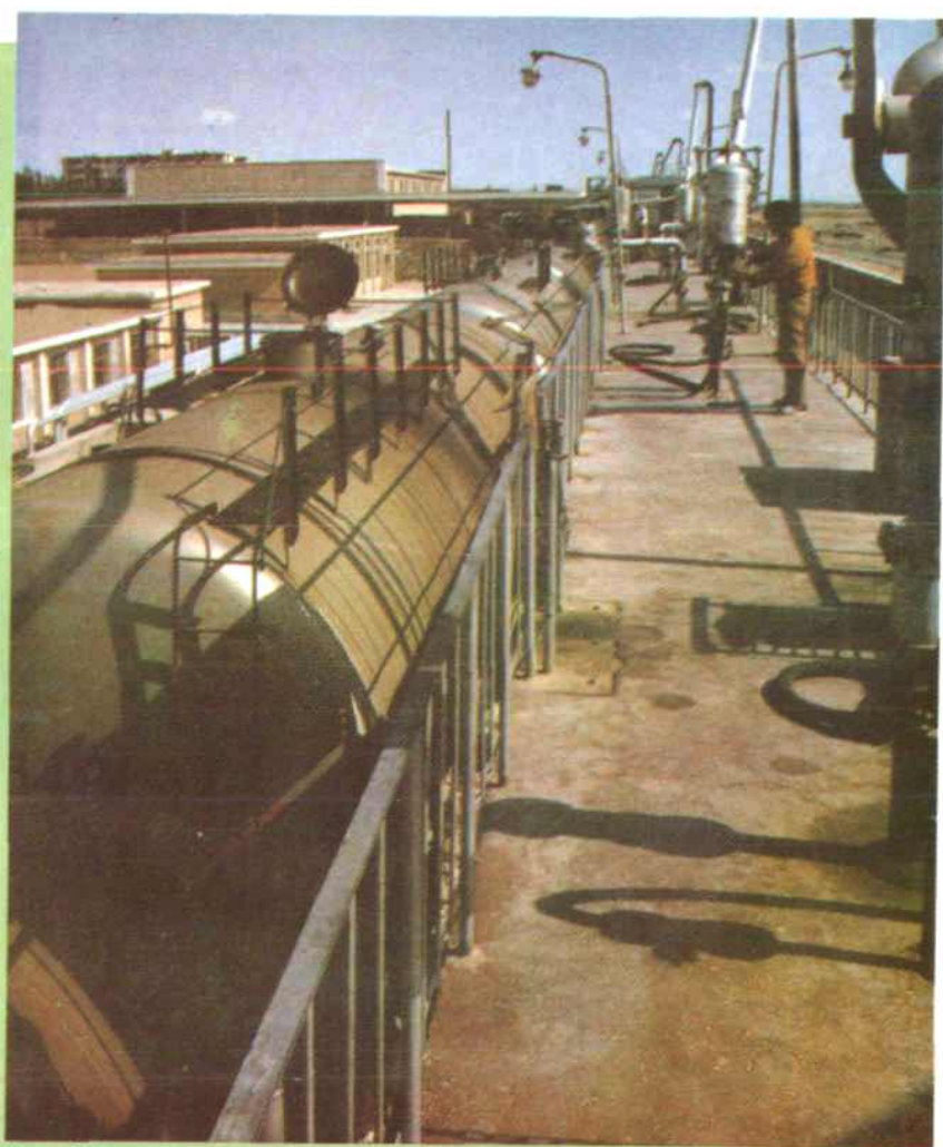
库尔勒分公司铁路栈桥
