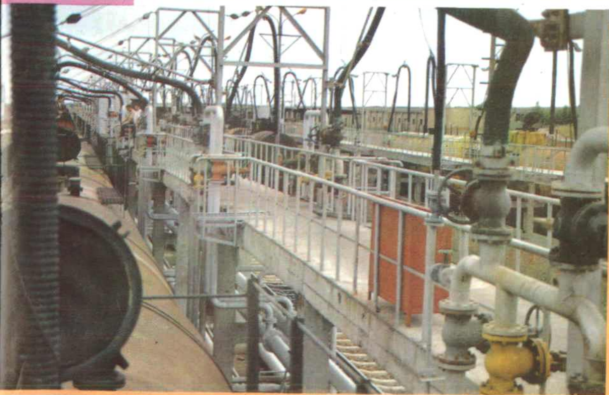
王家沟分公司铁路栈桥
