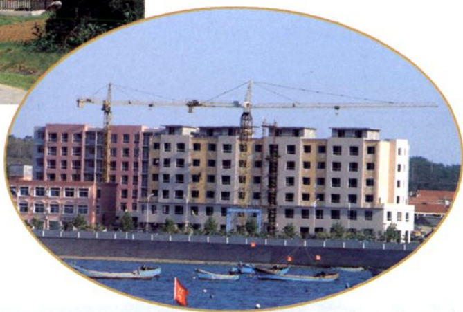
海景商品住宅楼落成
