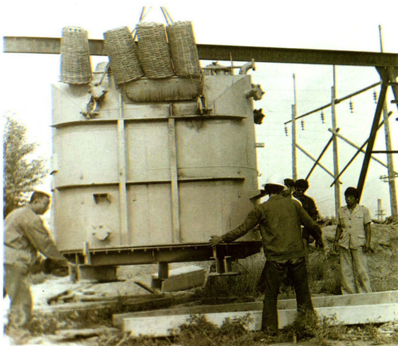
第一火电厂安装变压器。
