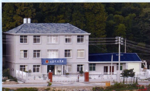
工商分局综合楼
