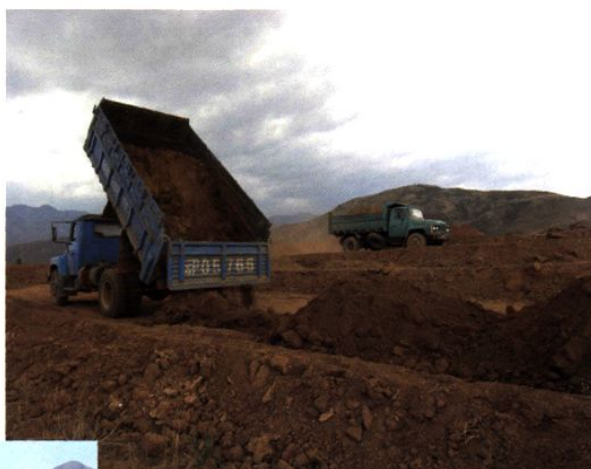
借土回填施工
