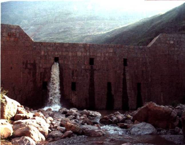
项目实施后的桥头河 拦砂坝工程
