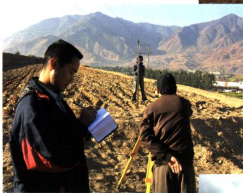
严格施工管理
