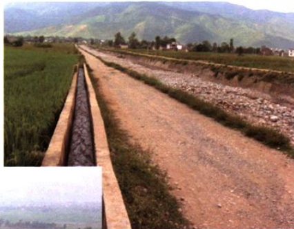
土地复垦整理后完善的道路和水利工程施工
