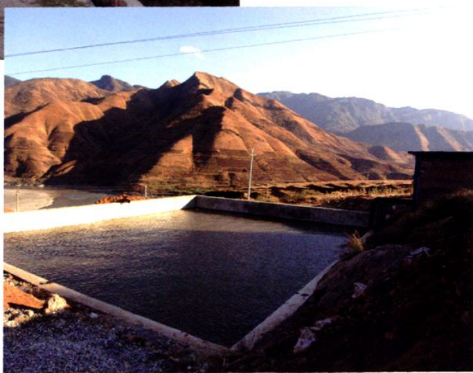
项目区水池、提水泵房
