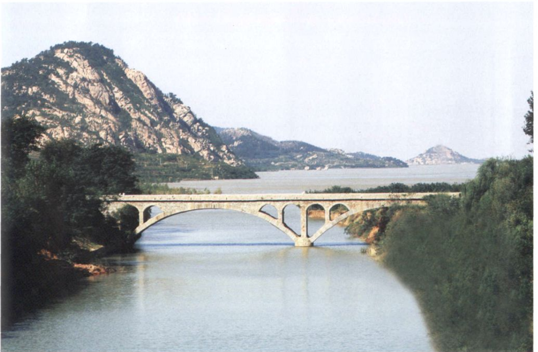
雄跨于崂山水库上游的凉泉桥
