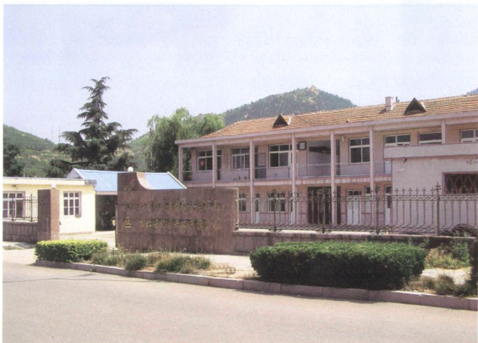
崂山区建设施工单位——北宅街道建筑公司
