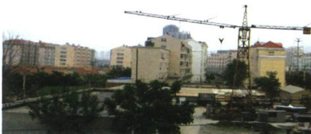
建设中的楼房
