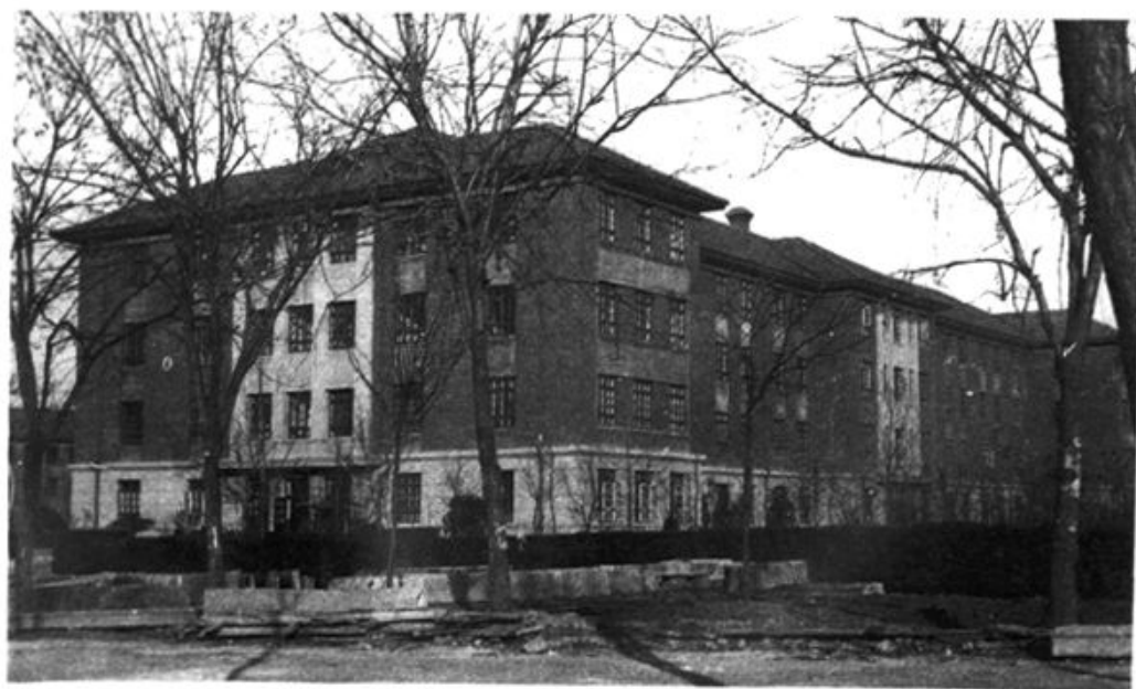
1957年建成的教学六号楼。
