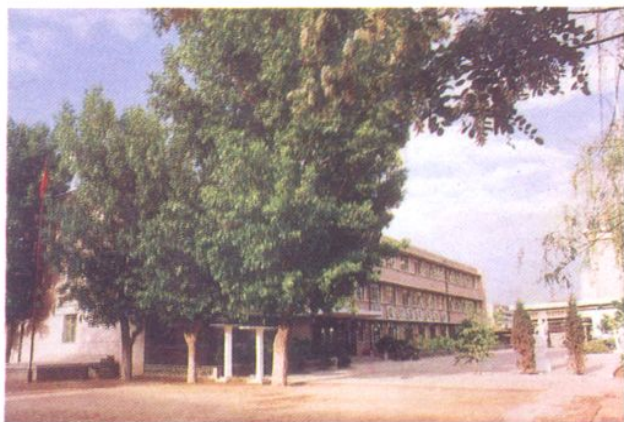
▲唐山市路北区实验小学教学楼
