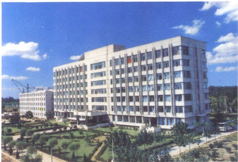
►开滦矿务局职工教育培训中心大楼
