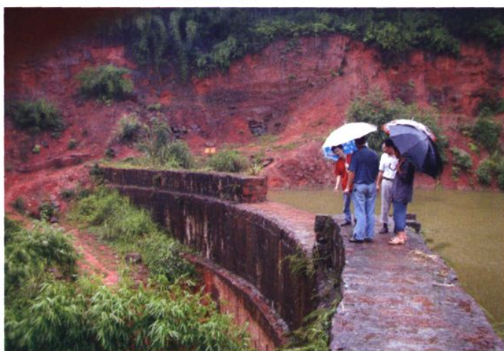
技术人员检查水库安全。
