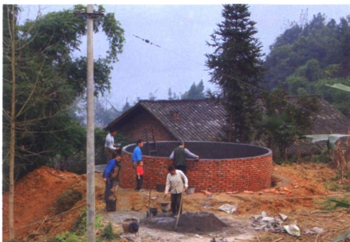
黄丹镇大碑村村民投资 修建饮水蓄水池。
