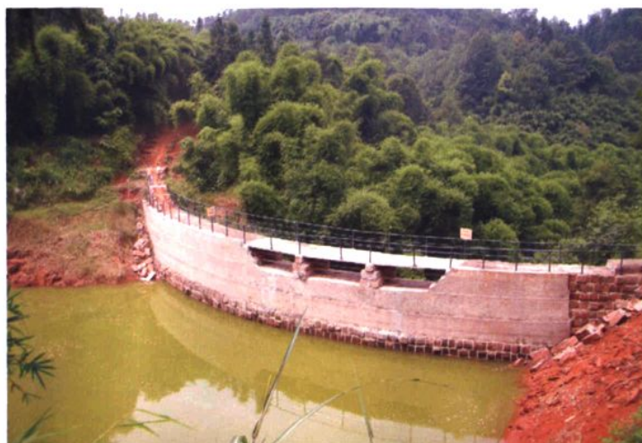
新建的石板滩水库人行便道全貌。
