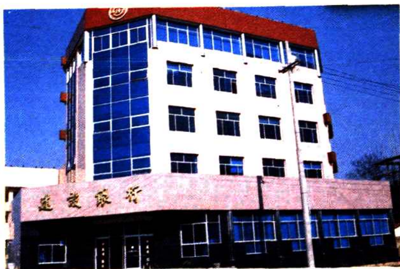
安吉县支行营业大楼
