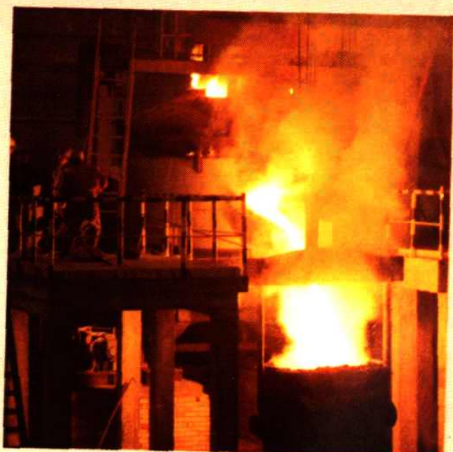
湖州钢铁厂扩建项目 3号炉开炉(年产钢锭16万吨)
