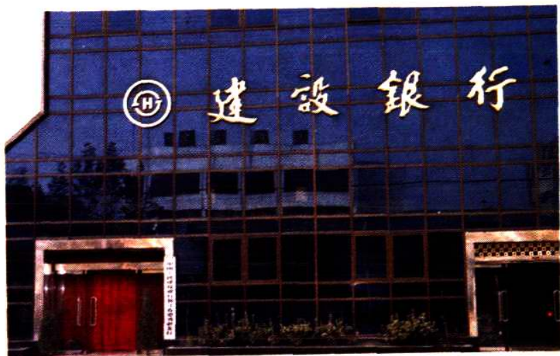
德清县支行营业大楼
