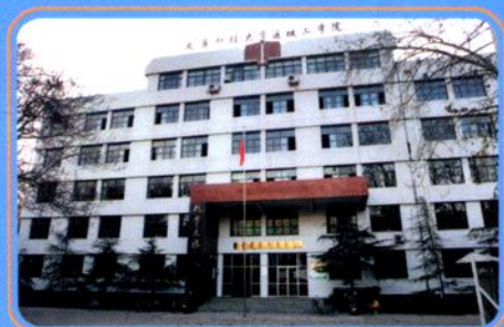
太原科技大学运城工学院东校区教学大楼
