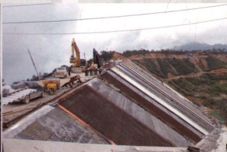
在建的亚洲最高落差电站——南山电站
