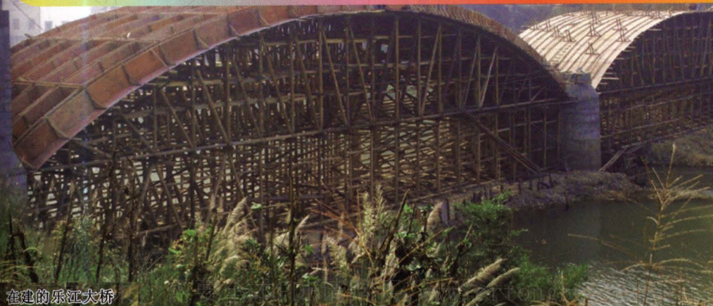
在建的乐江大桥
