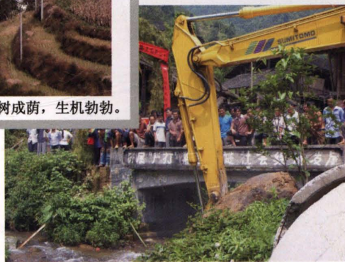
江底乡把“整村推进”作为扶贫工作的重中之重，多渠道筹集资金加大贫困村基础设施建设力度。图为2006年6月22日贝围公路破土动工。
