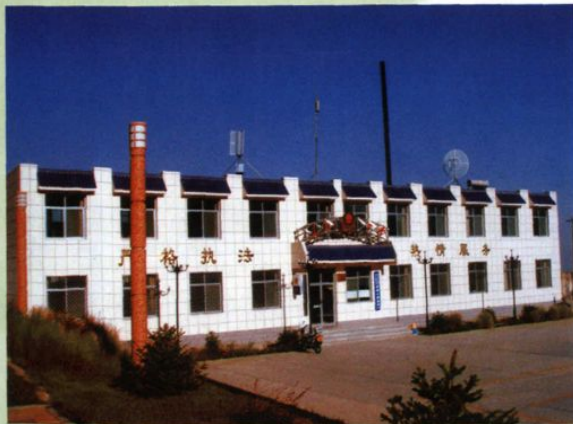
管理站、派出所
