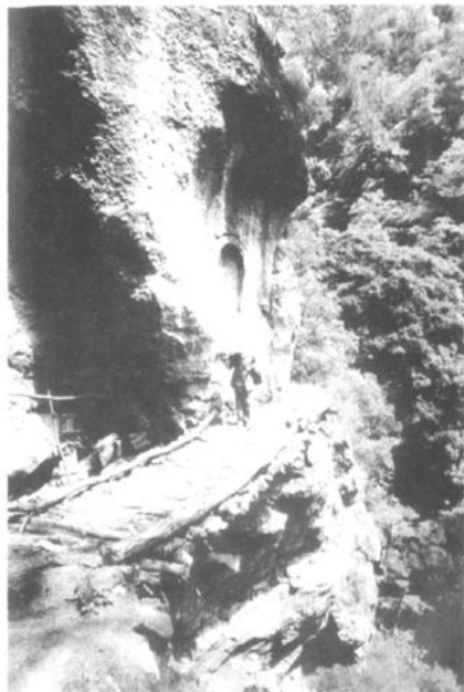
华亭麻庵古栈道
