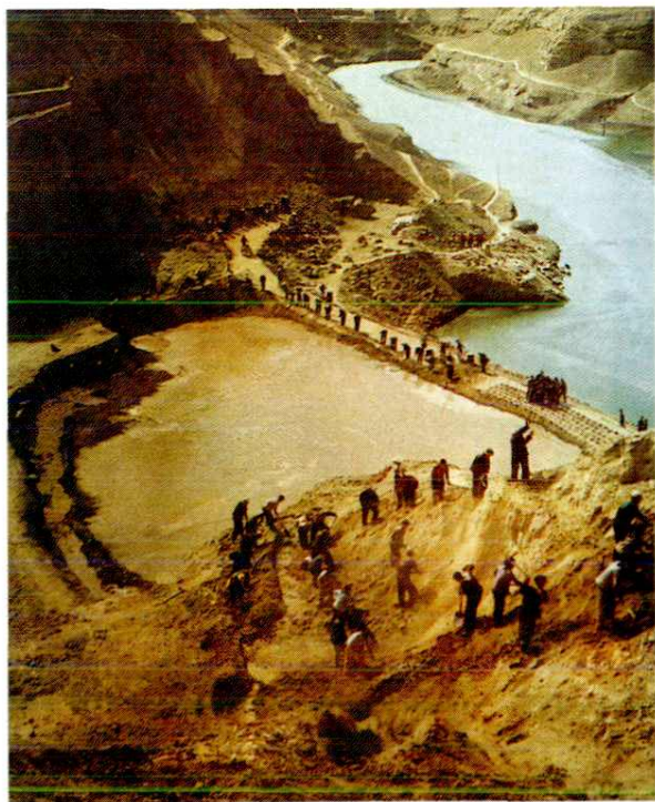
陕西吴堡县川口沟内水坠筑坝 (沈延大摄)
