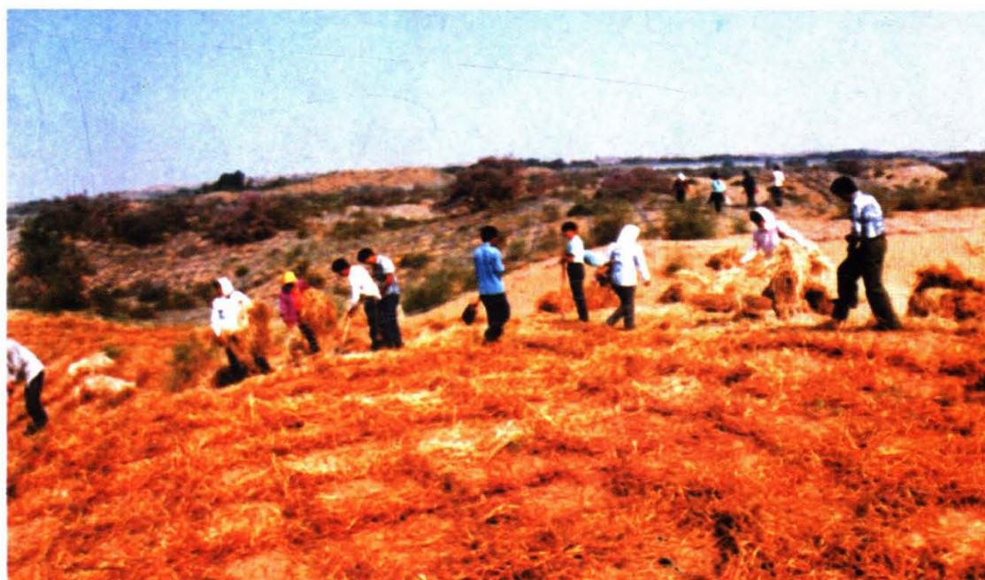
包兰铁路迎水桥至甘塘的55公里沙漠地段的流动沙丘上，中卫固沙林场扎设麦草方格沙障6万多公顷
