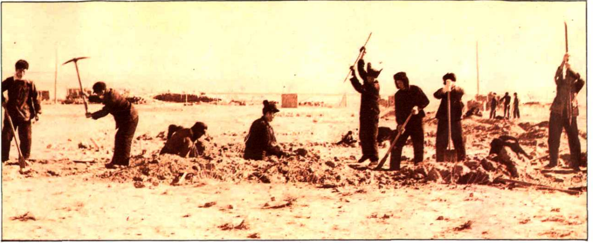
一期工程破土
