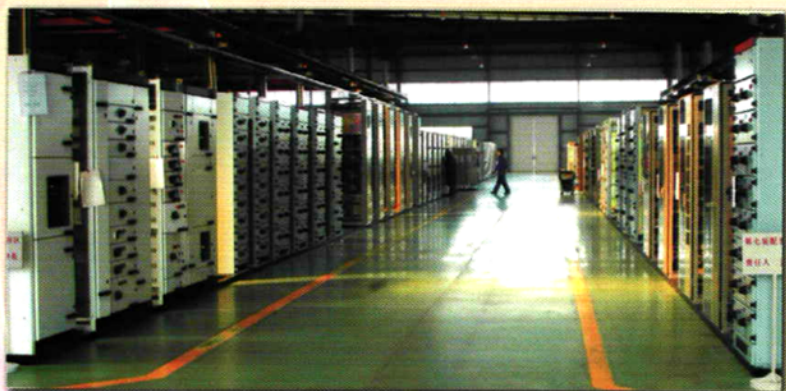
鑫龙电器公司低 压开关柜生产车间
