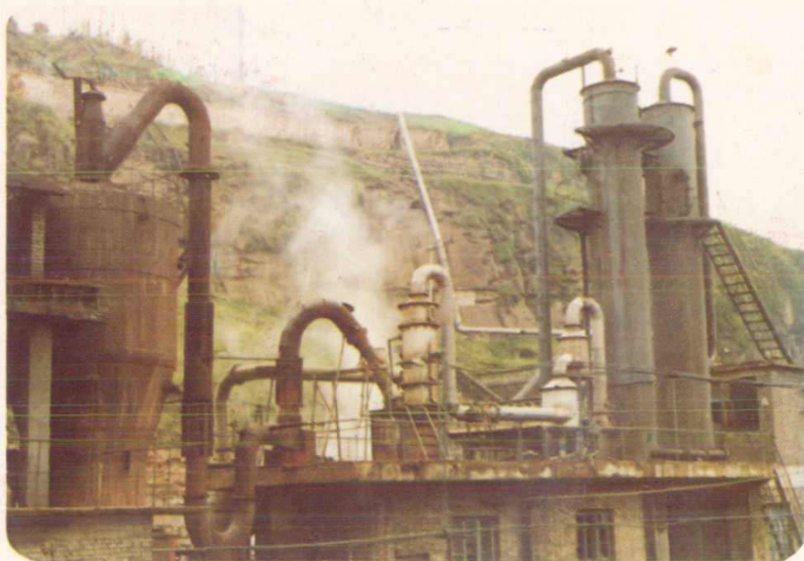
万县磷肥厂硫酸车间。向世荣摄
