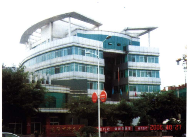
2003 年 6 月 26 日启用的德阳市卫生局新址
