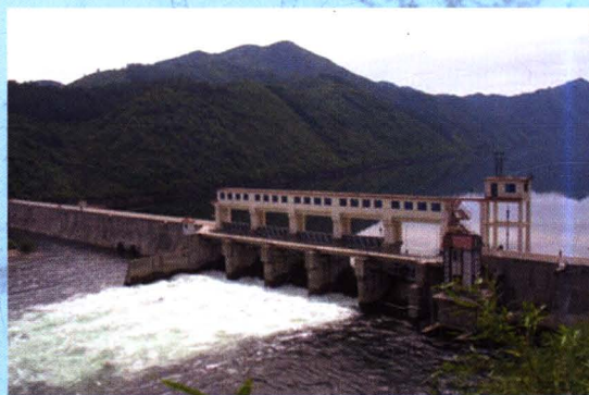
响洪甸抽水蓄能电站
