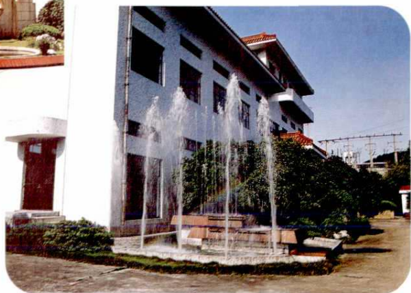
无人值班的 35 千伏铜山变电所
