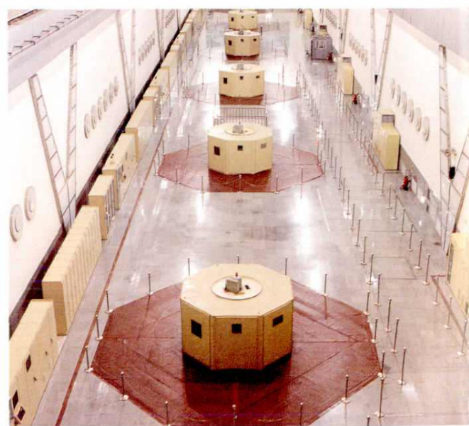
天荒坪抽水蓄能电站6 × 30万千瓦发电机组
