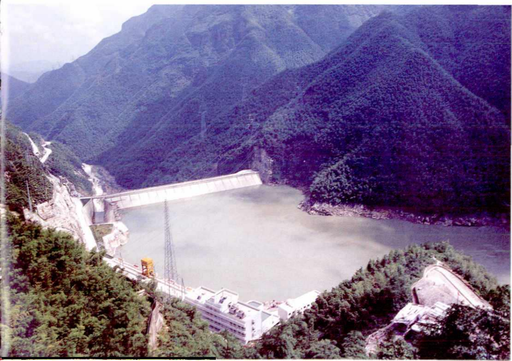
天荒坪抽水蓄能电站下水库
