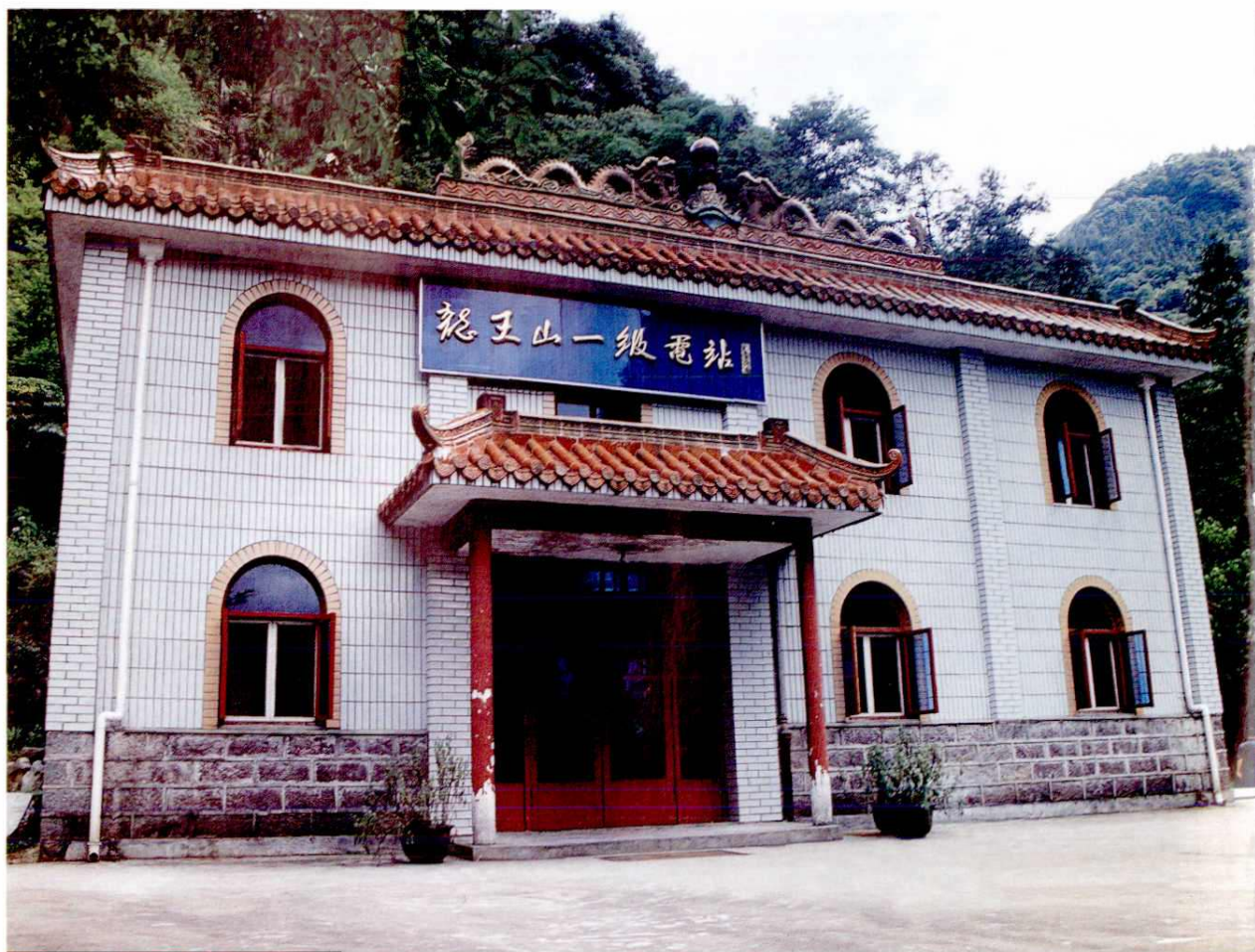
龙王山一级水电站
