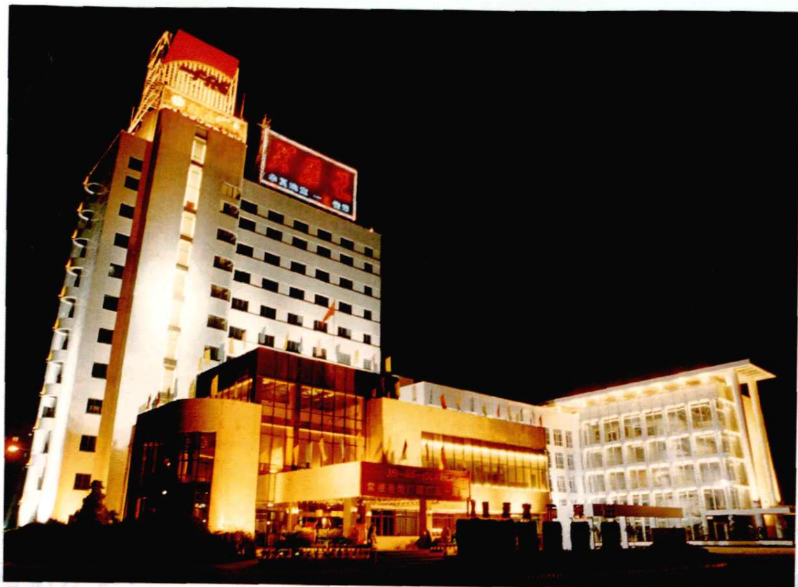
▲ 现厂办公楼，技术中心夜景。
