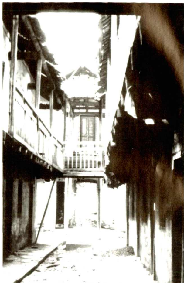
▲ 建厂初期河汊车间外景。
