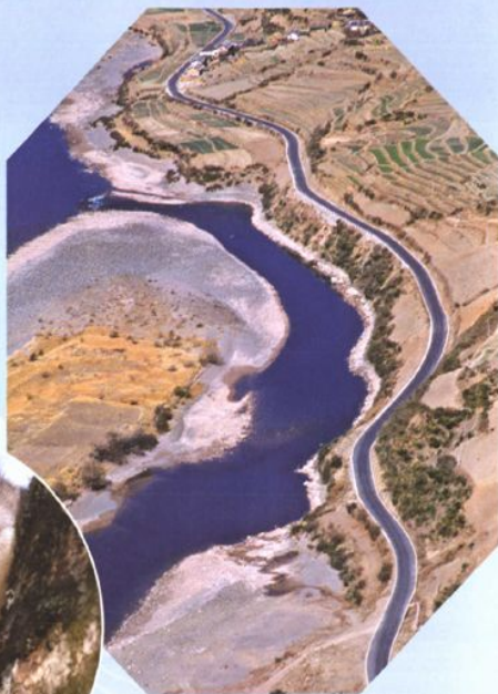
通县油路建设
