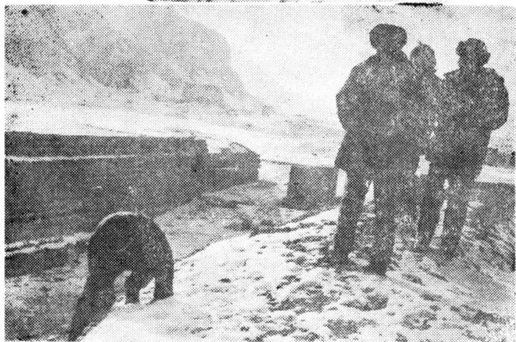
⑪头屯河东岸大渠进水闸
