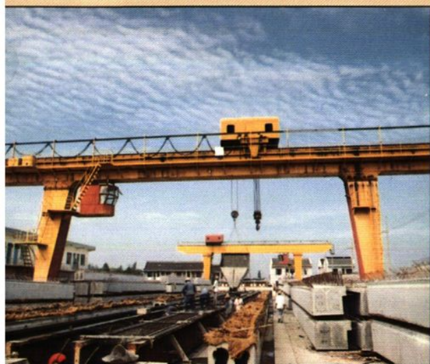
上海市政一公司混凝土制品厂金山分厂 生产的预应力桥梁
