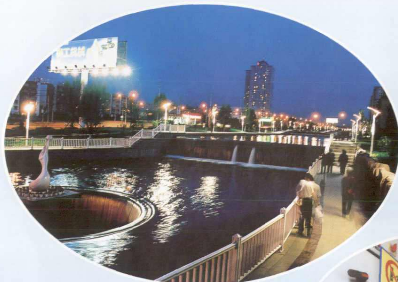
珠江路立交桥侧的和平渠改造工程——滨河园
