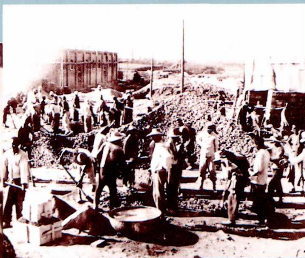
1935年8月16日 焦炉混凝土灌浆
