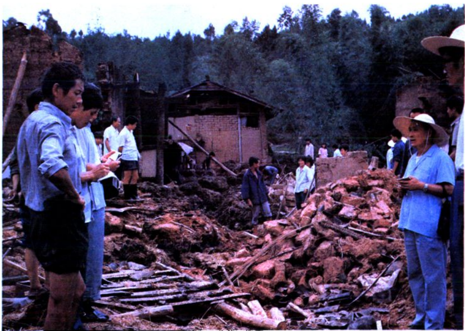
一九八一年遭受洪灾损失房屋。
