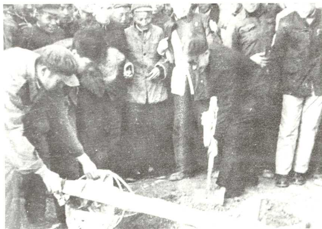
一期工程破土奠基
