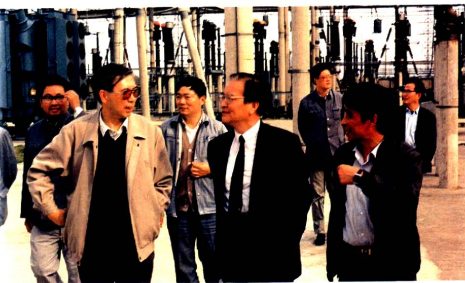
中电联理事长张凤 祥(中)在苏州供电局常 熟变电站现场(1990)
