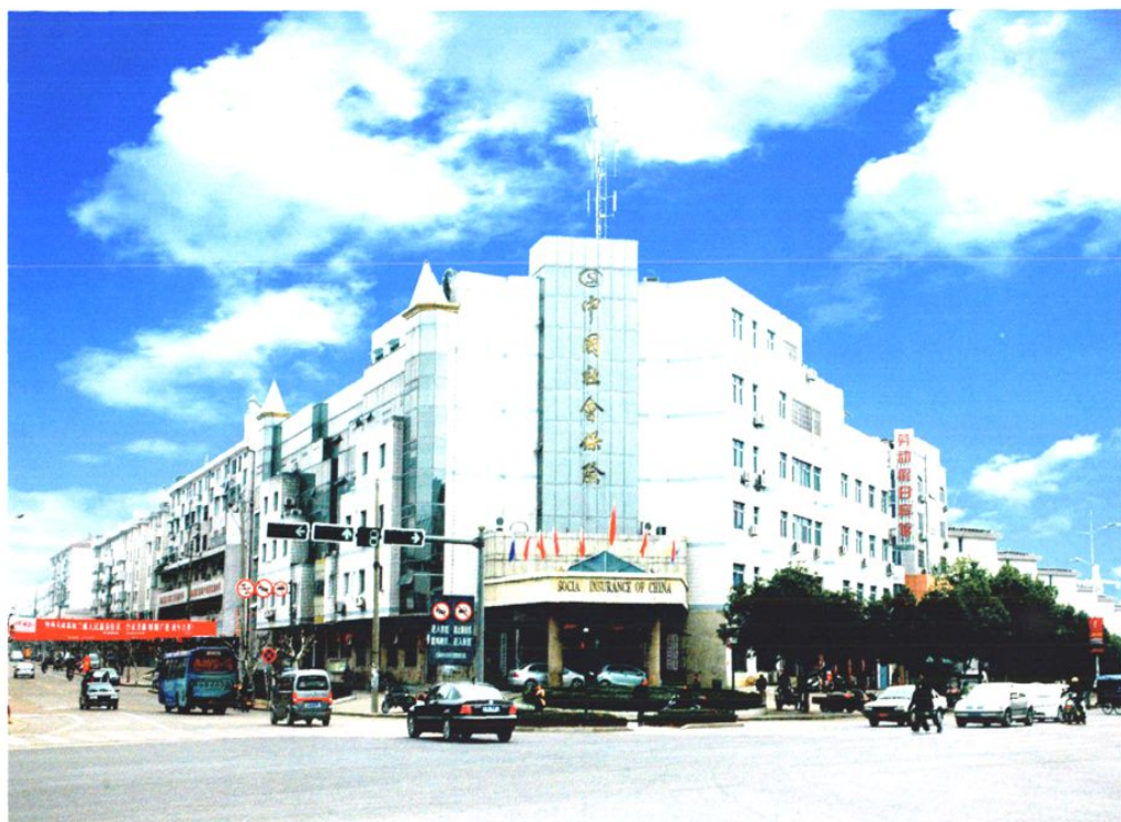
兰溪市社会保险大楼
