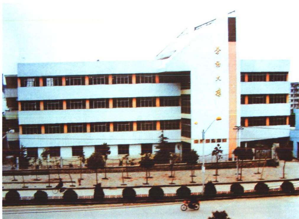
兰溪市劳动大楼
