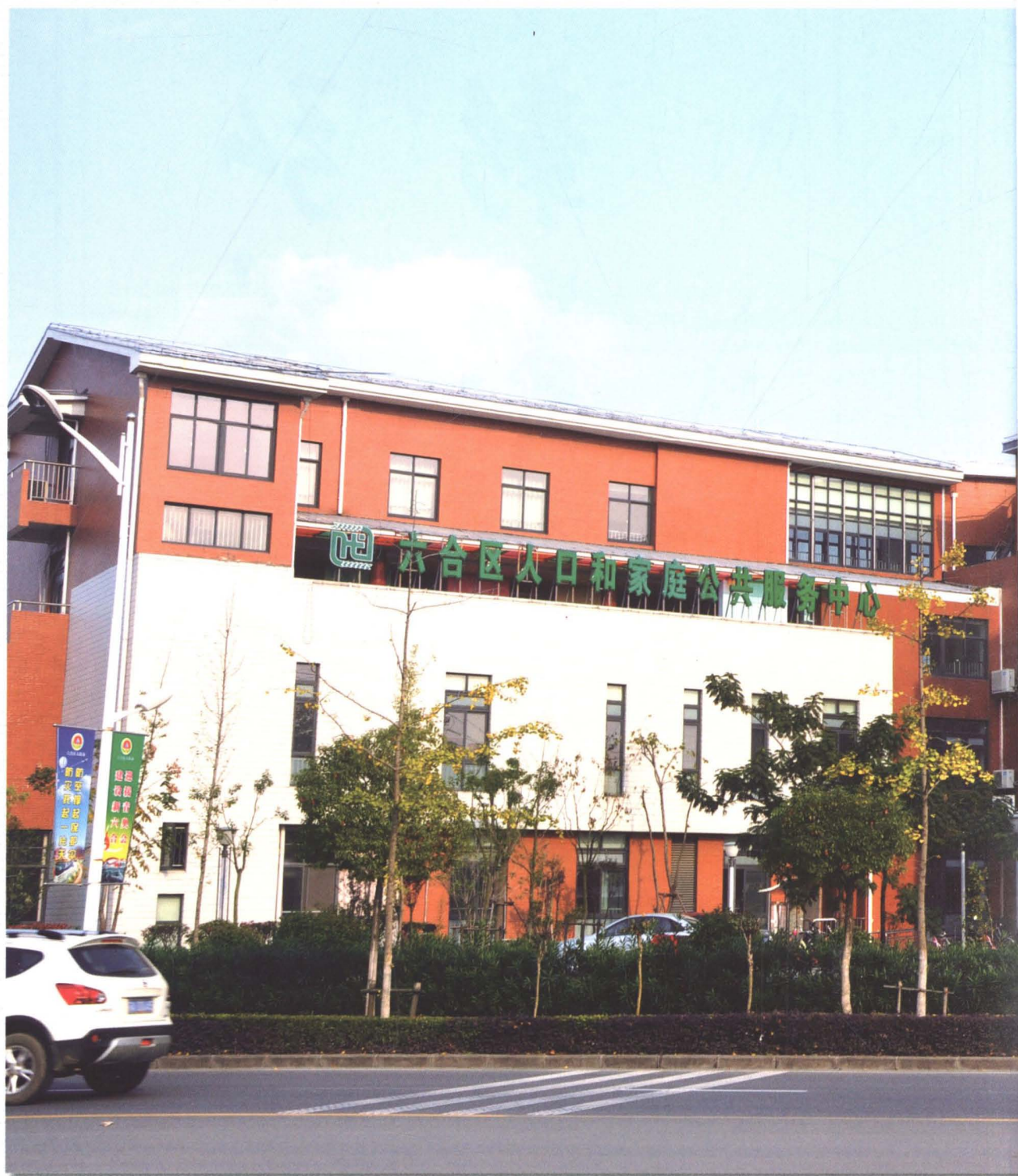
六合区人口和家庭公共服务中心大楼
