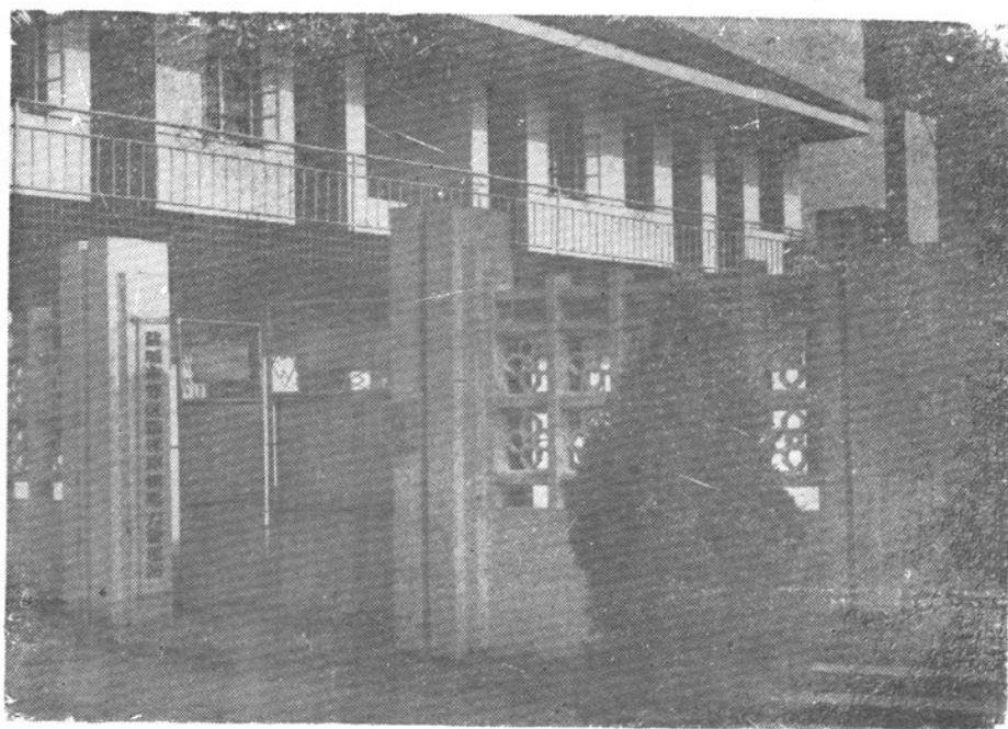
南洋岸镇电力管理站
