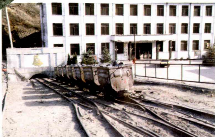
西冯街煤矿提升系统
