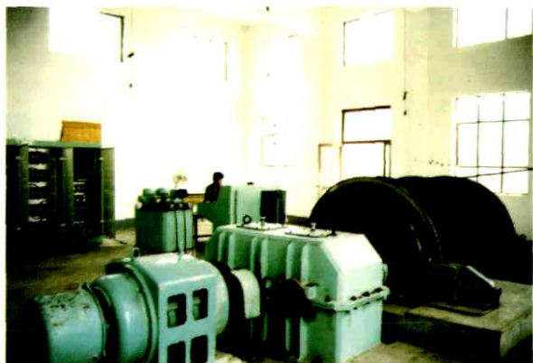
西沟煤矿崔凹坑口主绞车房
