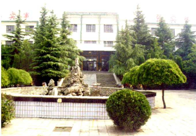
卧庄煤矿办公楼
