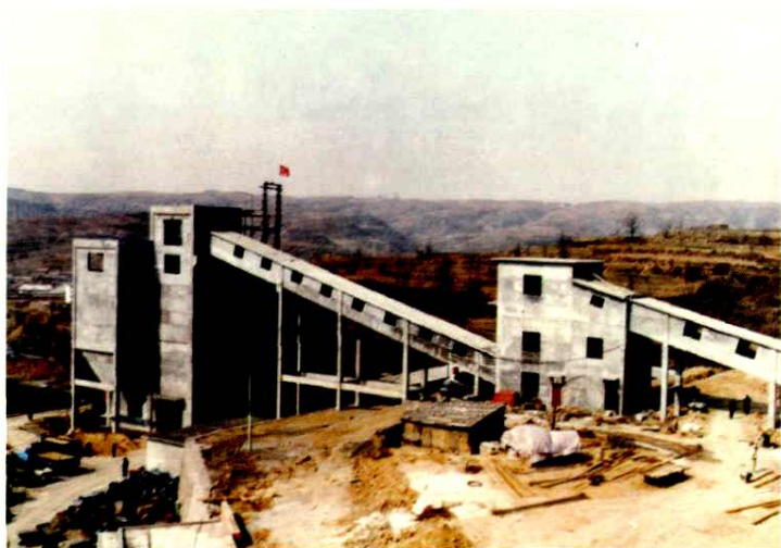
建设中的阳城选煤厂
