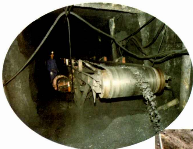
陕庄煤矿皮带运输顺槽
