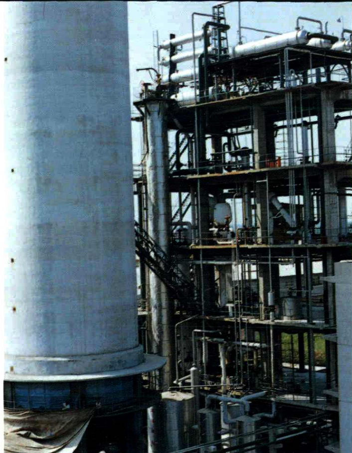
尿素设备及操作楼层
