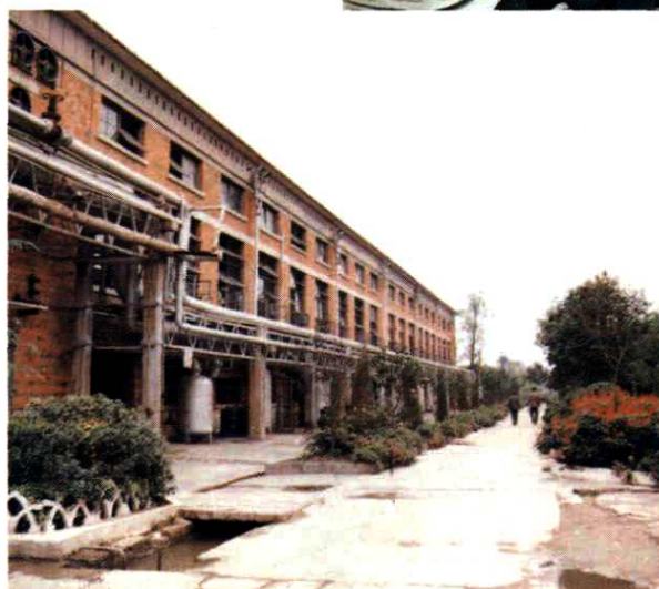
合成高压机房外景
