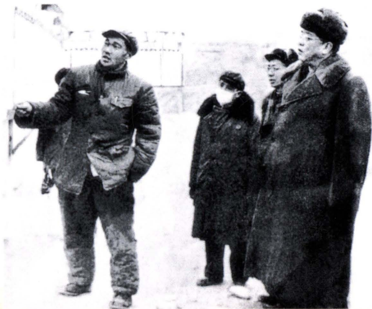
→ 原铁道部副部长武竞天在兰青线筑路工地检查工作。
