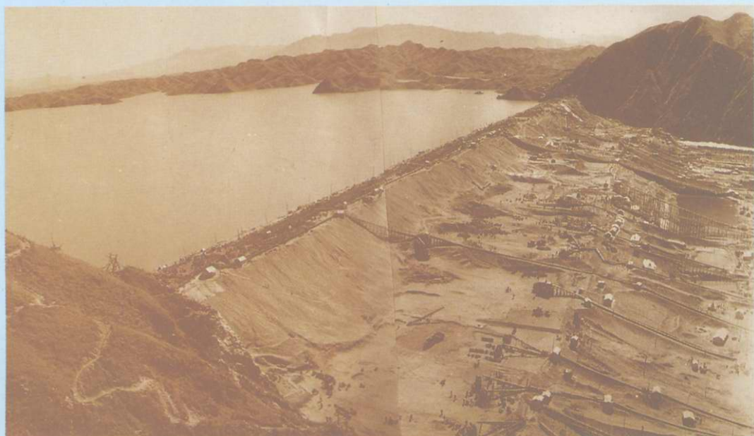
1959年修建中的密云水库大坝，首次拦住了大洪水， 为水库1960年的胜利建成创造了条件。
