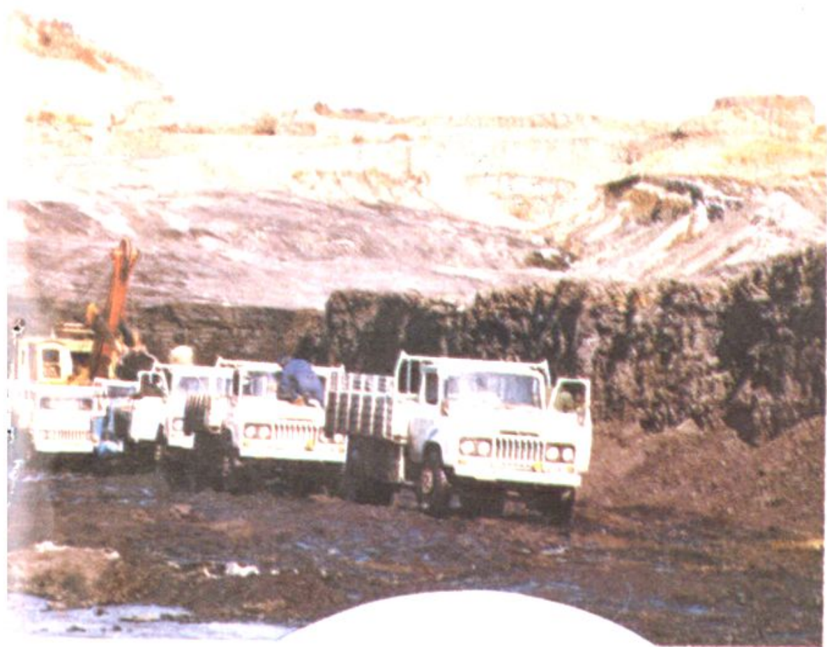
采煤作业现场
