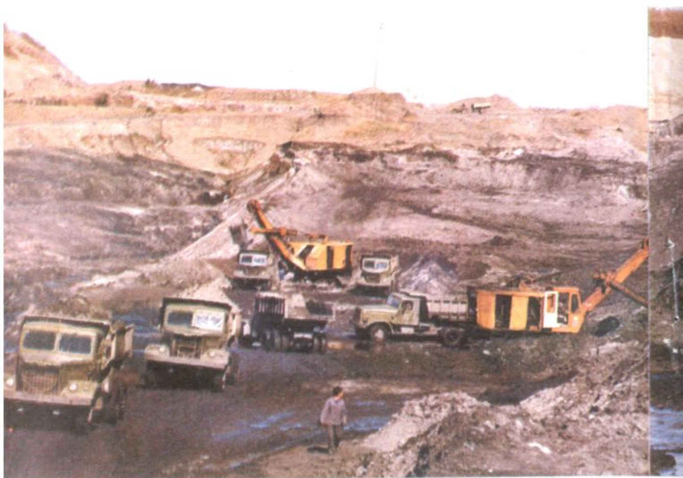
剥岩作业现场
