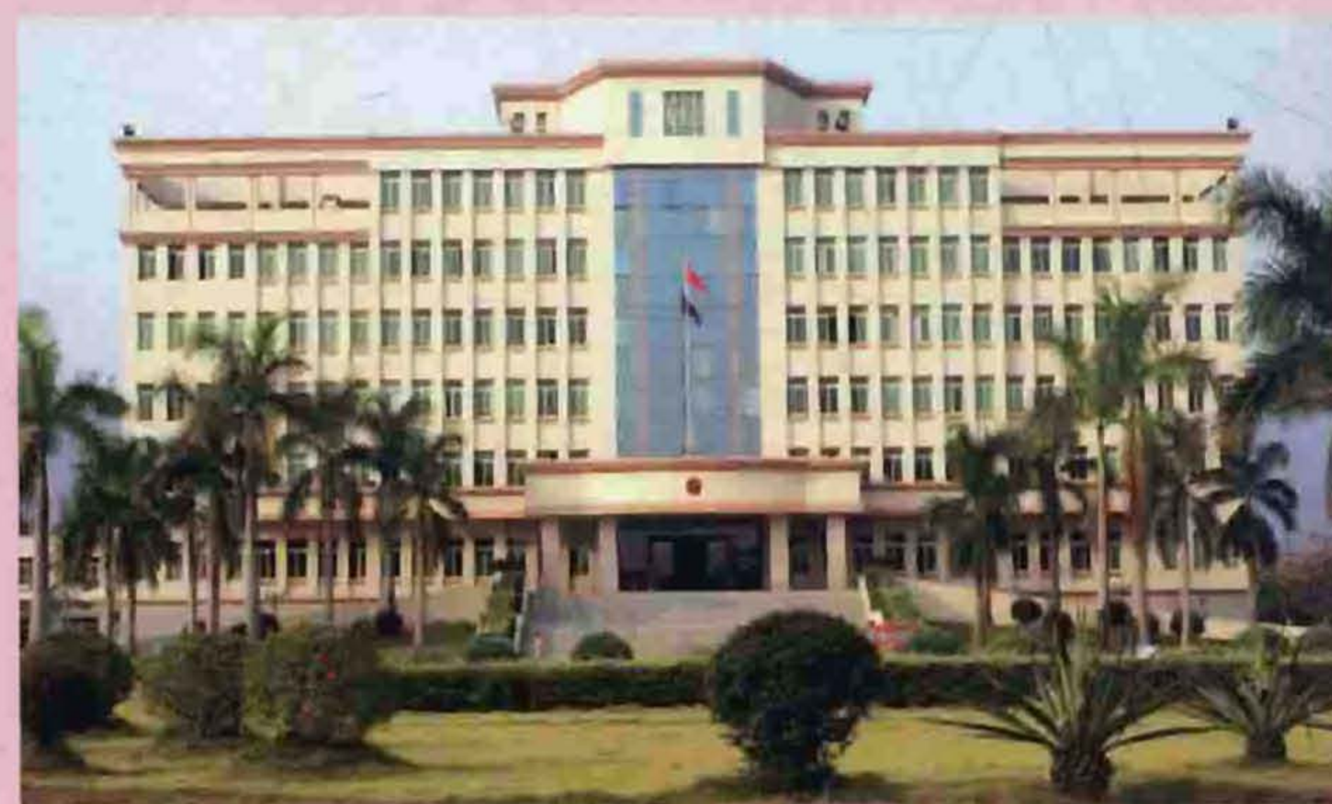
东城街道办事处办公大楼
