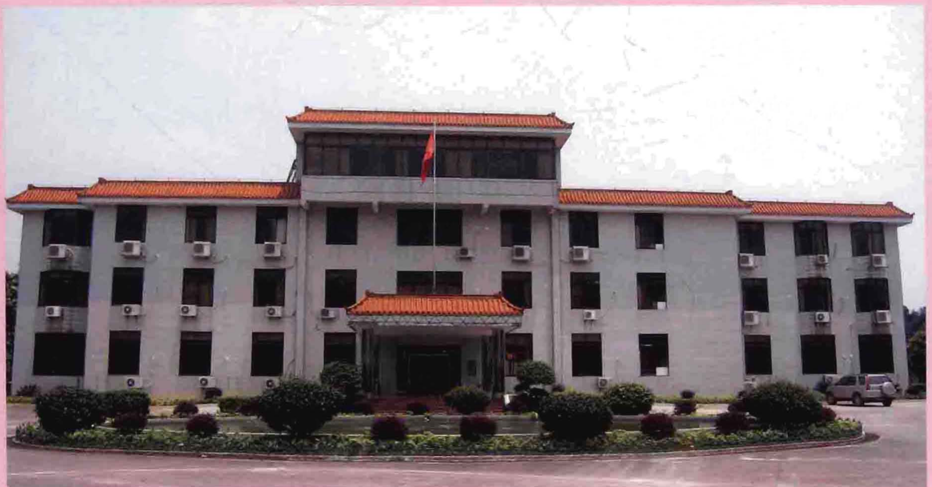
银盏林场场部办公大楼
