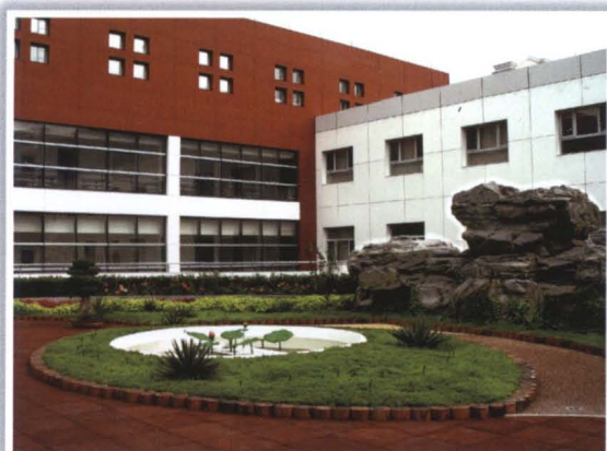
中国残联办公楼屋顶绿化
