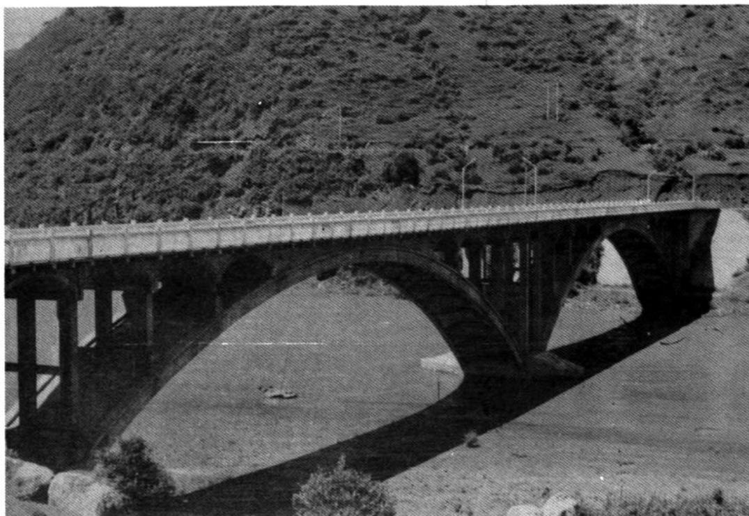
漠沙江大桥：系1986年1月1日开工，1987年12月30日竣工，桥长168.2公尺，宽5.5公尺，是云南第一座转体施工的大桥。
