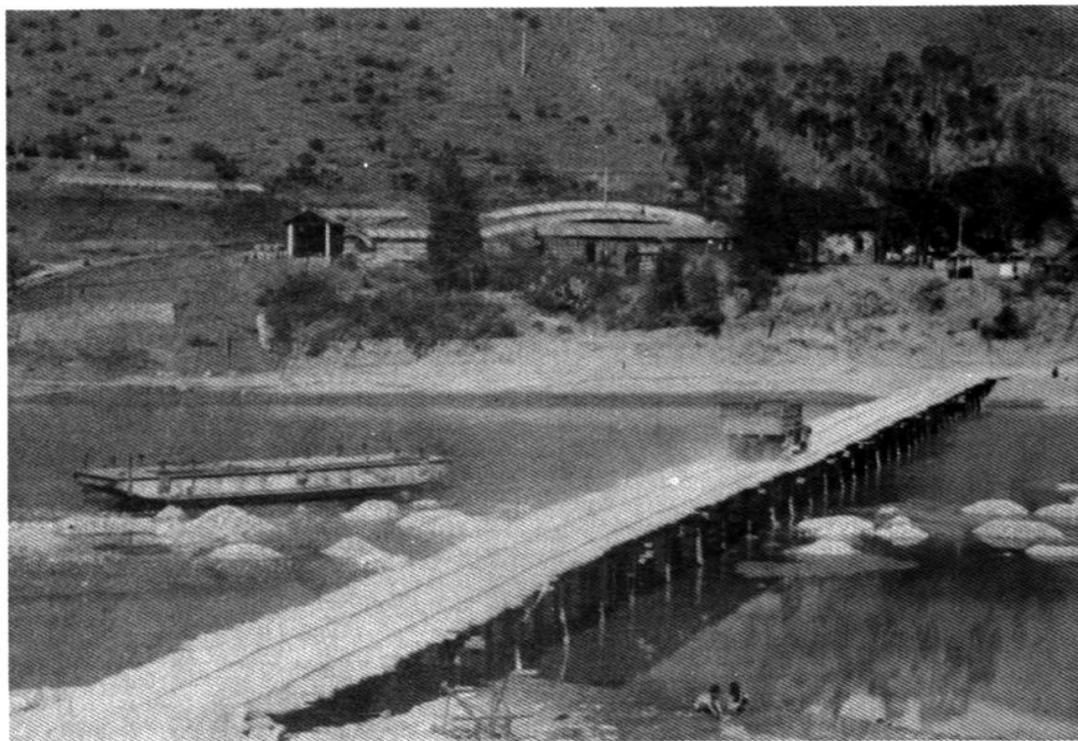
漠沙江大桥的前身—木便桥（如图右）1971年开始架设至1987年，为了拉运甘蔗，每年11月中、下旬架设，第二年5月中下旬洪水到来前撤除。全长120—125公尺，载重负荷2万千克。
