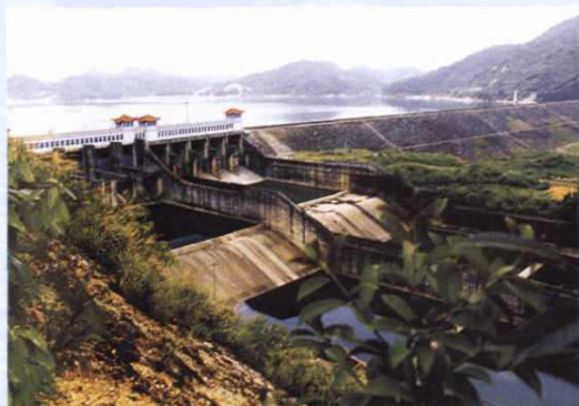
实习基地嵊州南山水库
