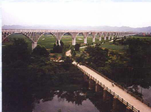
实习基地永康杨溪水库灌区渡槽
