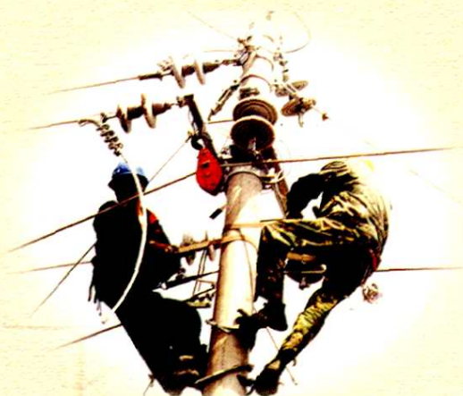
农网改造施工现场
