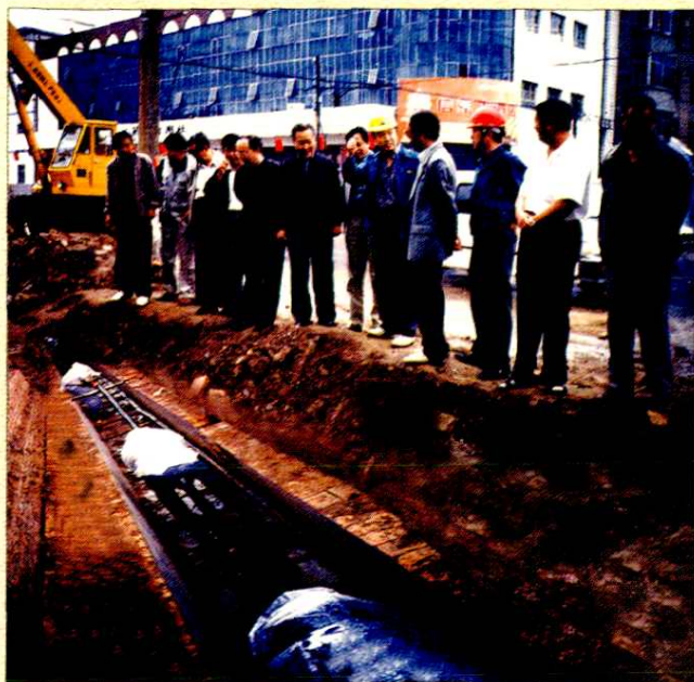
祁县四大班子领导视察城网改造
