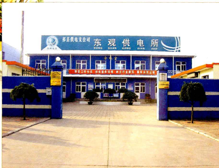
祁县供电公司东观供电所
