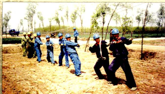
农网改造施工现场
