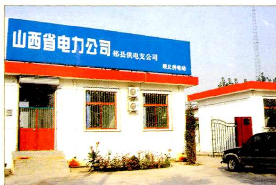
35千伏晓义变电站（站所合一）
