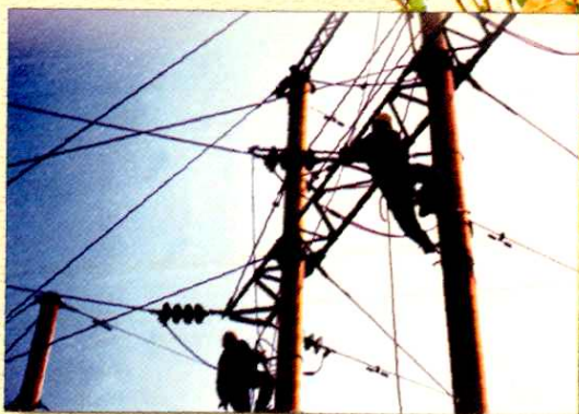
35千伏输电线路春检现场
