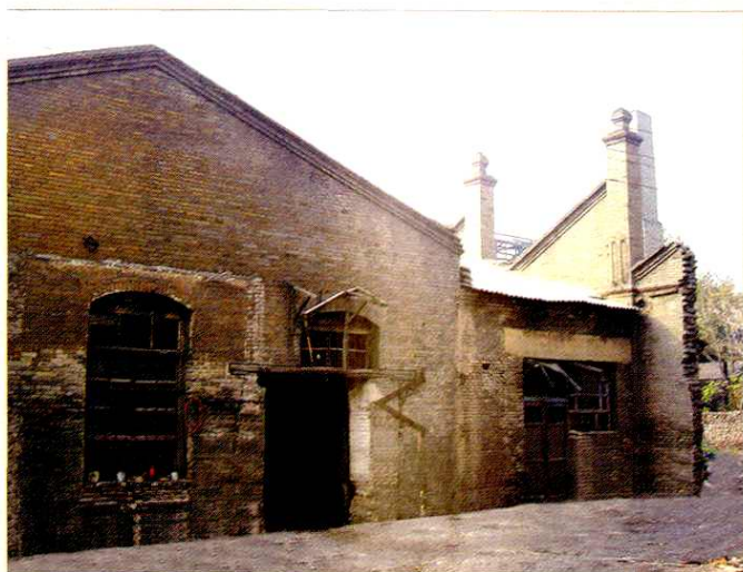
祁县铁工厂发电车间旧址
