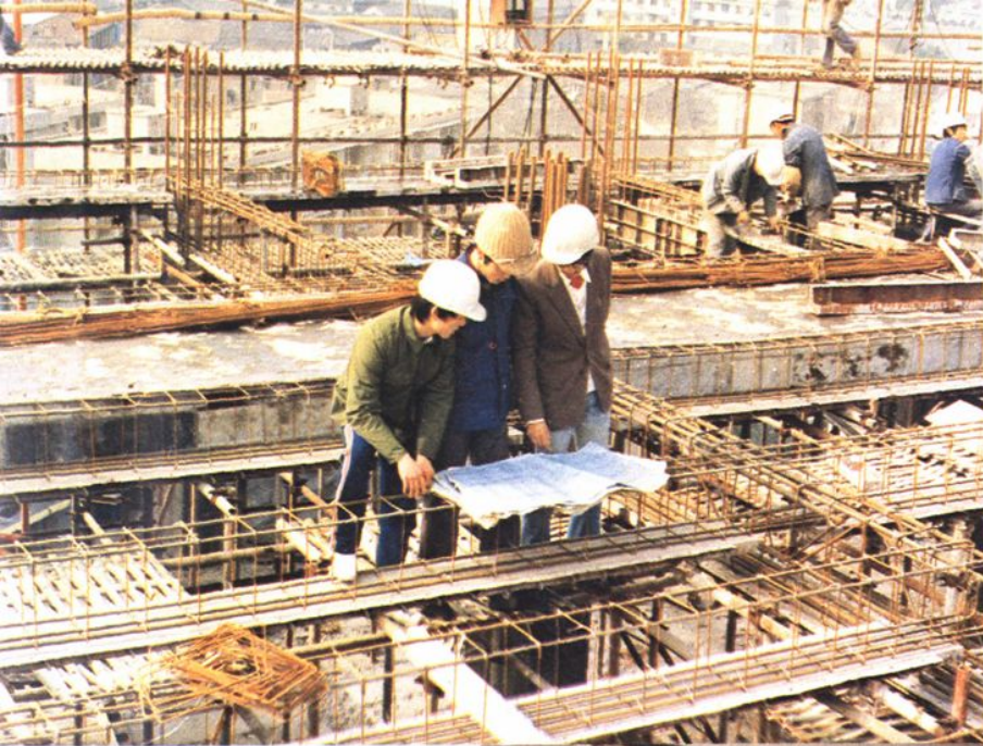
绍兴城建职工中专学生在建筑工地实习。
