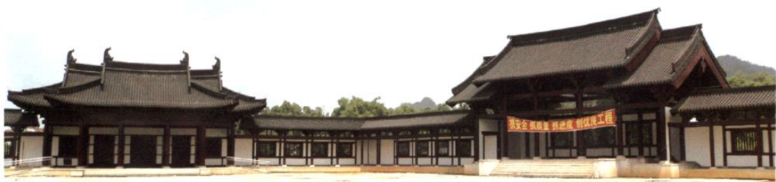
▲ 建设中的东方禅文化园南门区（局部）（2010年摄）
